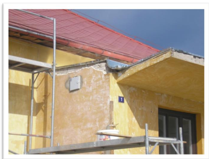
Výměna střešní krytiny na vchodové části
