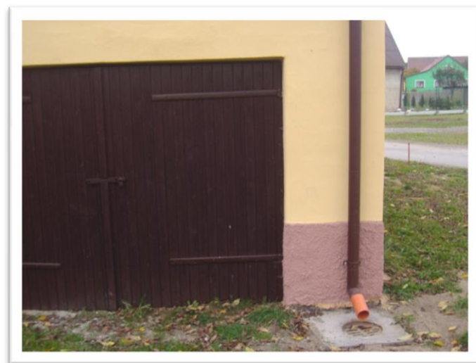
Neodtékající kanalizace, voda stékala pod zdivo
