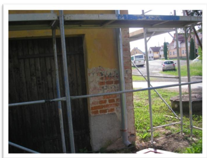
Neodtékající kanalizace, voda stékala pod zdivo
