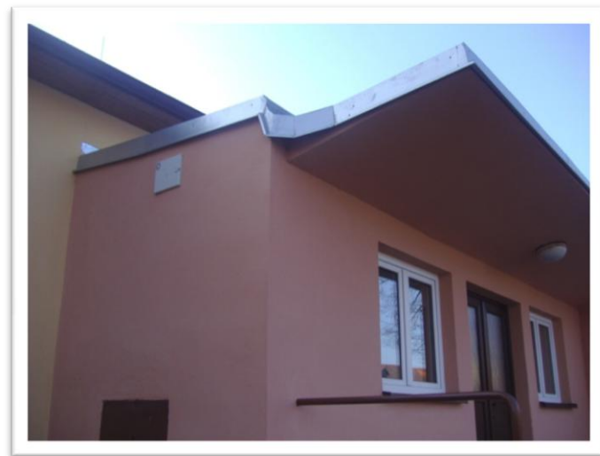
Výměna střešní krytiny na vchodové části
